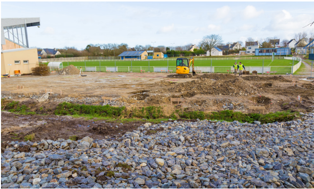
Réalisation des fondations de l'espace Pierrot-Ménéz
