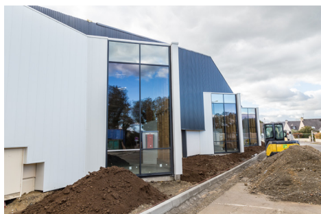
Réalisation en cours de la seconde phase ; le gymnase
